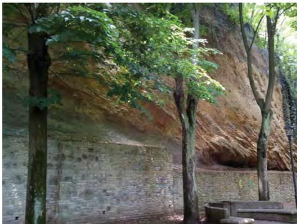
**Fig. 4 - La bancata calcarenitica costituita dai sedimenti del mare pliocenico affiorante lungo il viale delle Rimembranze. Su di essa poggia le proprie fondamenta l'intero borgo medioevale.**
